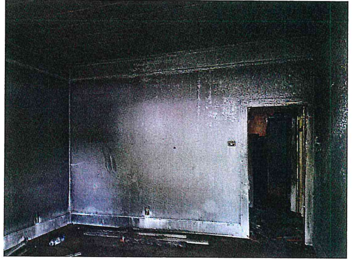
4/19/2016 517 A&B - INTERIOR A SIDE Pic (04).jpg
