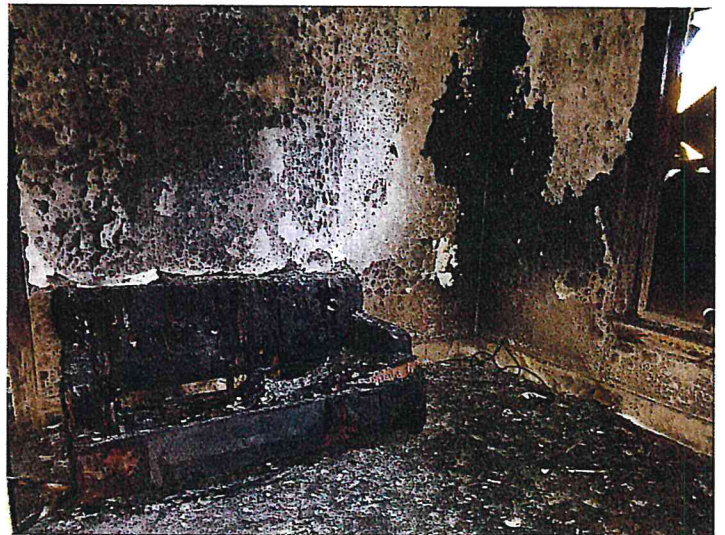
4/19/2016 517 A&B - INTERIOR A SIDE Pic (06).jpg
